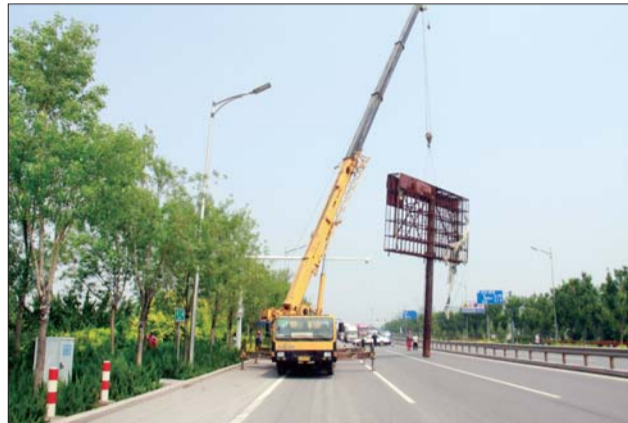
工作人员拆除违建中。
