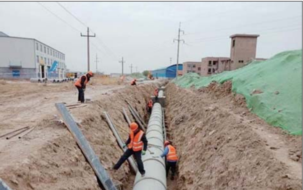
施工现场。(通讯员供图)
