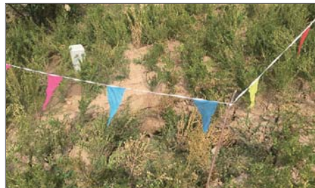
北一路与沂州路路口向西200米路北污水井旁的塌陷。
