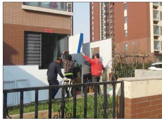
执法人生人员对违建进行拆除。(图片由通讯员提供)
