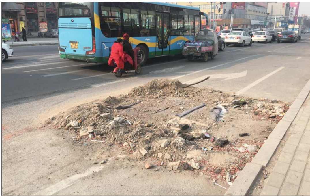
施工后的现场,石块散落、泥土堆积,给过往行人造成不便。
