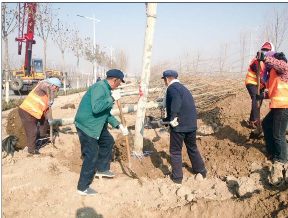
东青高速西侧绿化工程进入乔木种植阶段。 本报记者 段学虎 摄
