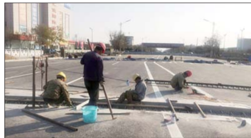
15日下午,工人正在进行伸缩缝填充施工。 本报见习记者 赵环宇 摄
