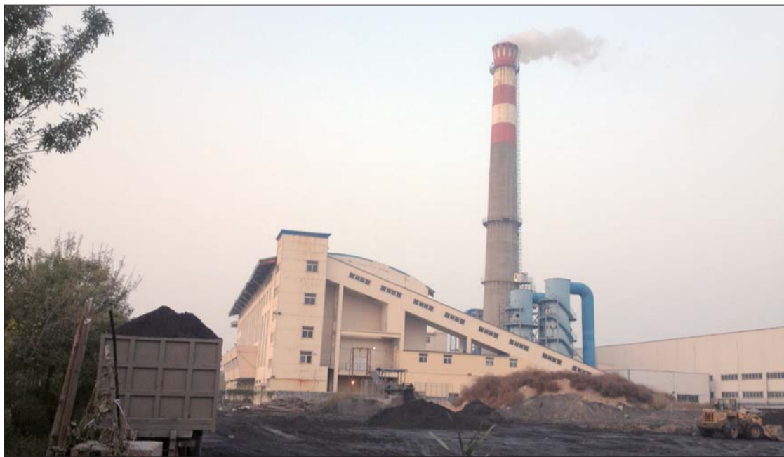
市供热处登州路4号供热站开始烘炉。 本报记者 段学虎 摄
