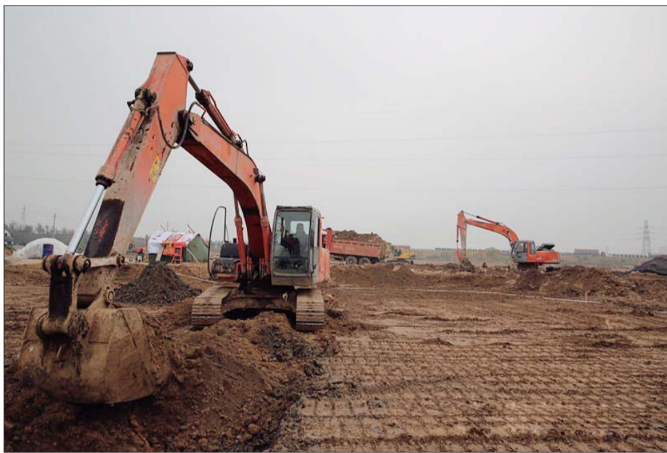
施工现场,大型机械进场。 通讯员提供
