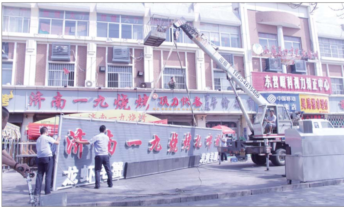
执法人员拆除违规门牌匾额。(通讯员提供)
