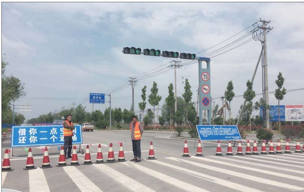
东二路与潍坊路交叉路口已被封上,除施工车辆外不许其他车辆通行。
