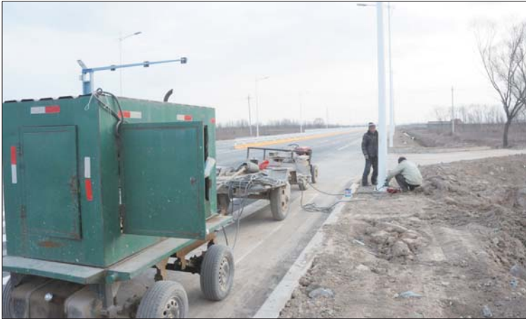
11日下午，庐山路上，工人正在安装调试路灯。 本报记者 段学虎 摄
