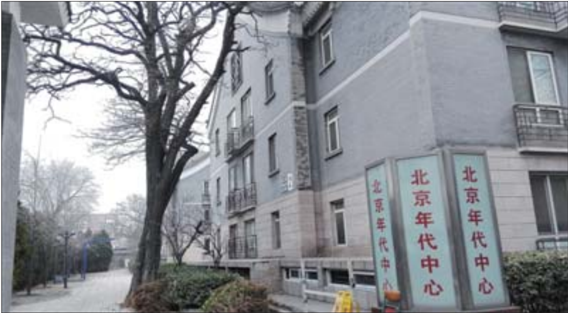
北京前马厂胡同60号院1、2号楼,被曹永正买下作为北京年代公司的总部。院子西侧这棵老槐被曹永正称为摇钱树。
