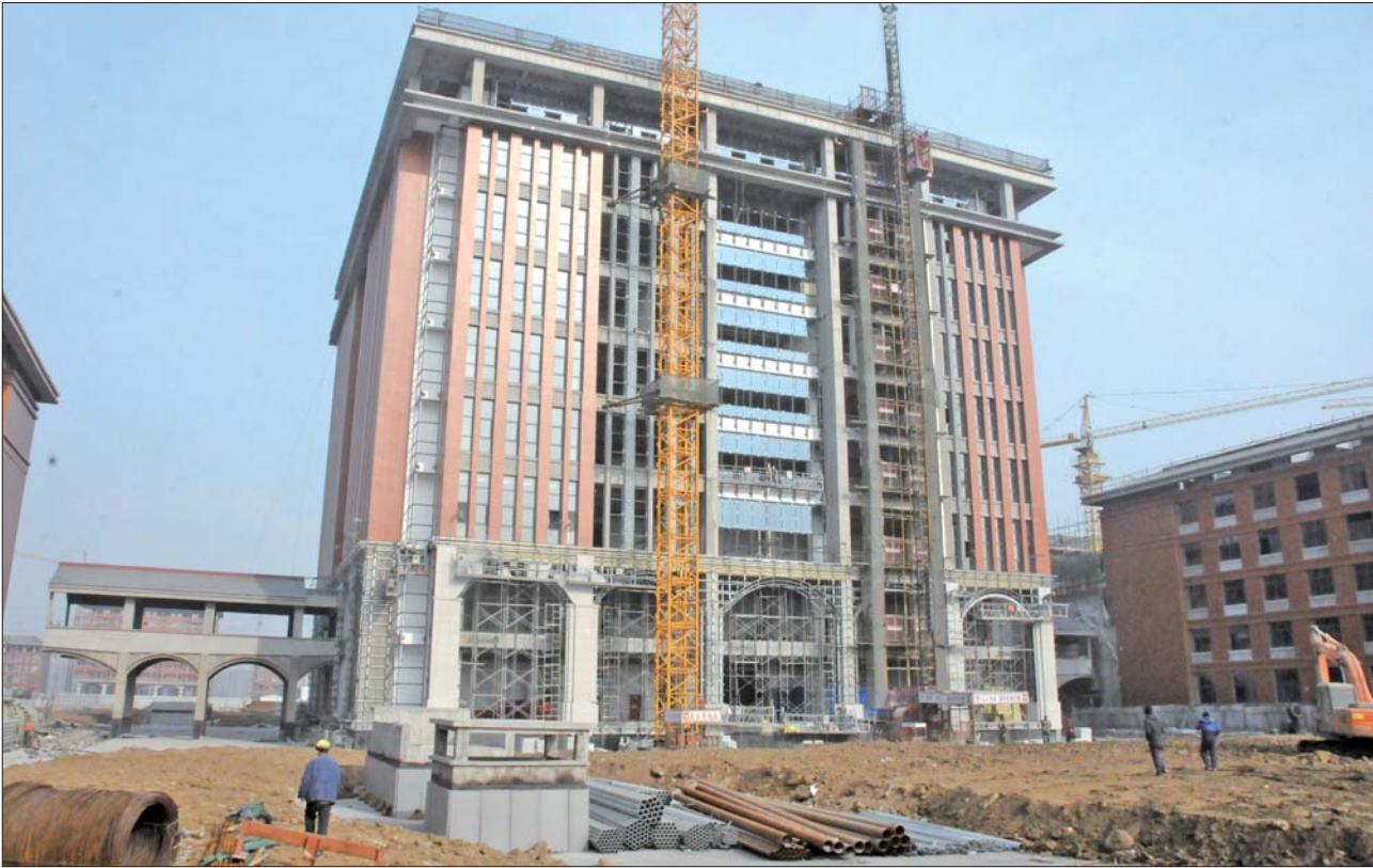
东营市二中新校图书综合楼进入外装阶段。本报记者段学虎摄
