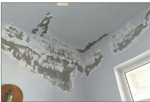
长时间的渗雨漏雨造成住户家中墙皮大面积脱落。本报记者 解岩 摄
