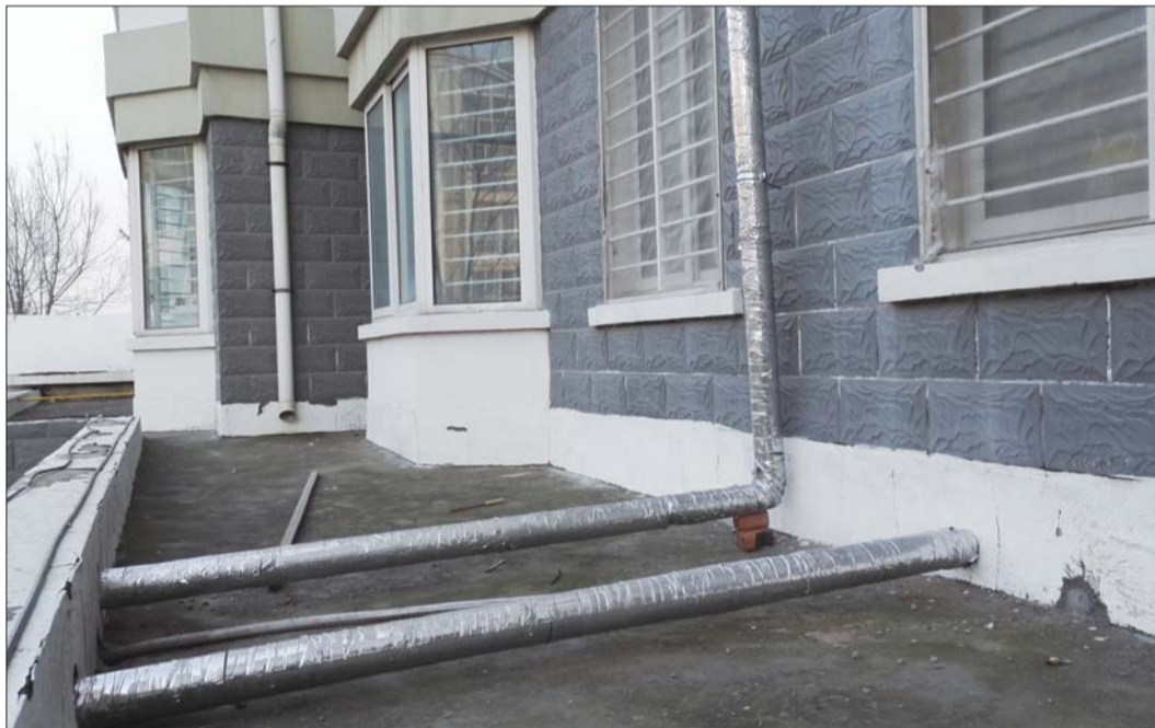
一楼和二楼改出的管道裸露在墙体外面。 本报记者 聂潇潇 摄
