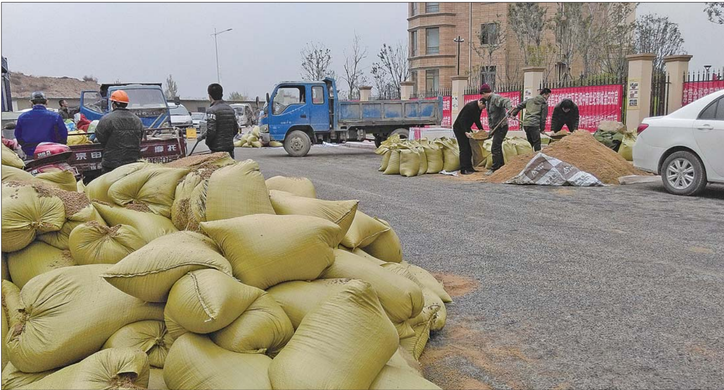
16日,中南世纪锦城门口,业主正在将散装的沙子装袋。
