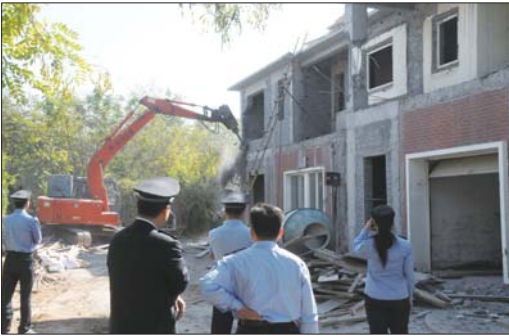
执法人员对城区一处顶风违建进行拆除。(资料片) 本报记者 段学虎 摄
