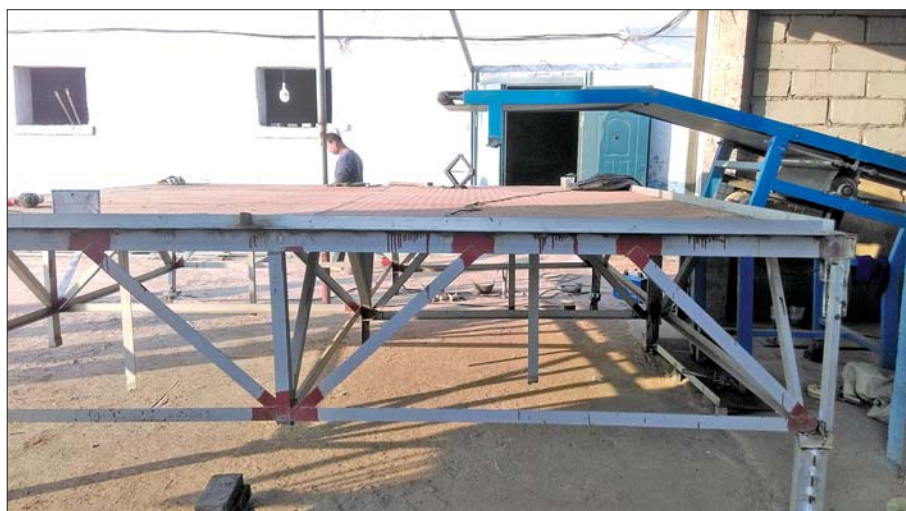
东营中通快递的新分拣平台正在建设中,建成后将大大提高快件分拣效率。
