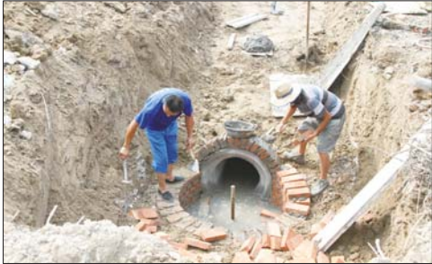
工人正在施工。 通讯员 提供
