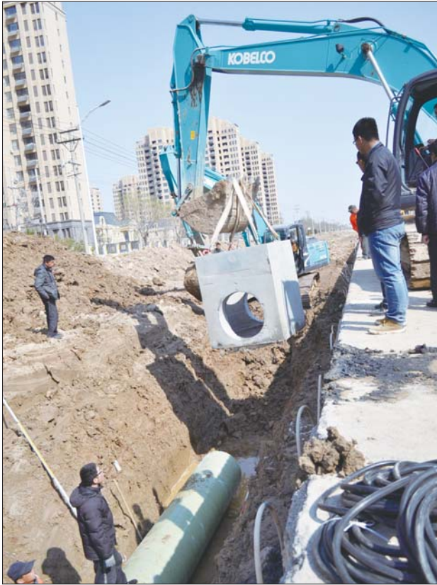
东四路改造工程中,工作人员正在安装污水管线。 记者 孙娜娜 摄
