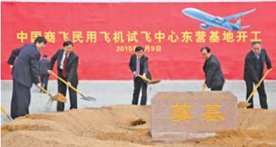
9日上午,试飞基地奠基开工现场。(图片由通讯员提供)
