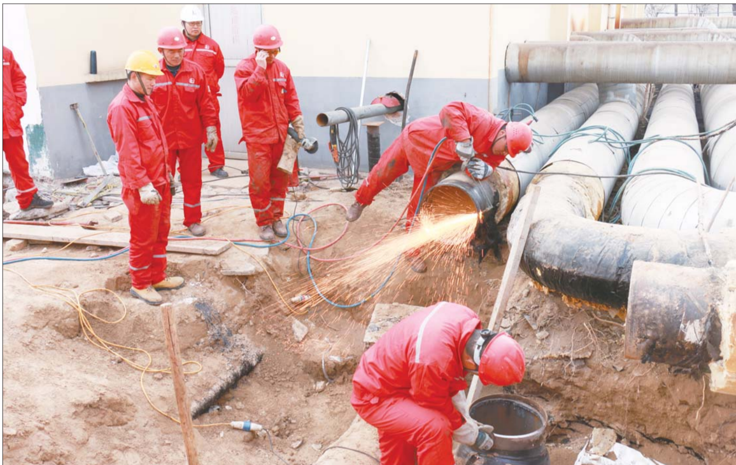
东营原油库一级动火作业现场动火施工。
