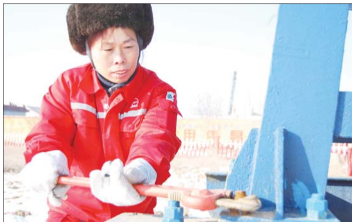
贺小红在维修保养抽油机。
