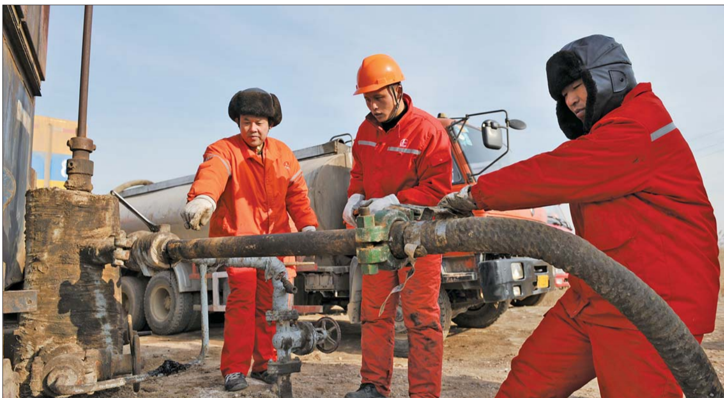
采油队员工连接井口管线至油罐车，做好替套准备。
