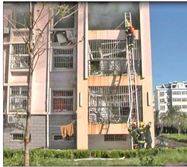
东营公安消防支队救援现场。(图片由通讯员提供)
