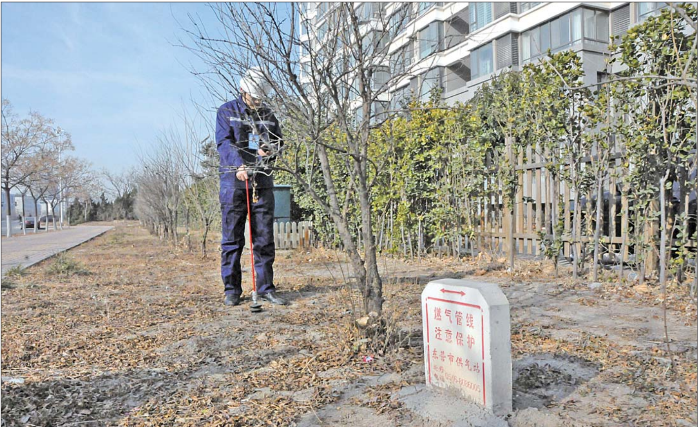
东营市供气站工作人员检查天然气管道。(资料片) 本报记者 段学虎 摄
