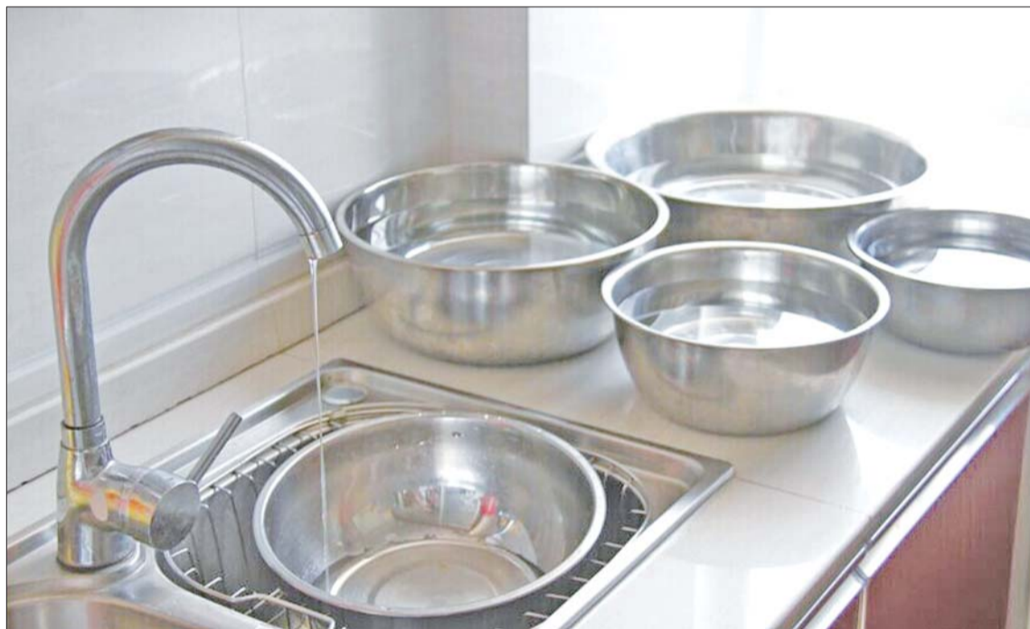
7月份奥林匹克花园小区住户家里的水流量。水龙头开到最大也只能这样细水流。(资料片) 本报记者 魏菲 摄
