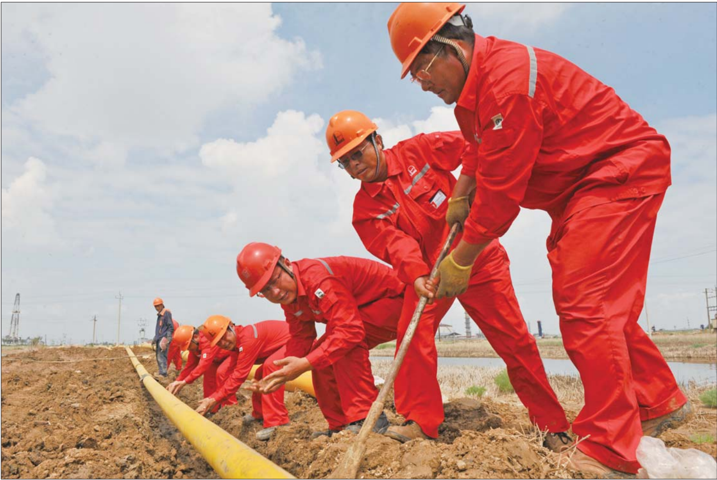
鲁胜公司扎实开展管线隐患排查,加大隐患治理力度。
