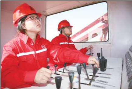
石油工程技术研究院科研人员在机械采油现场施工。 通讯员 任厚毅 提供
