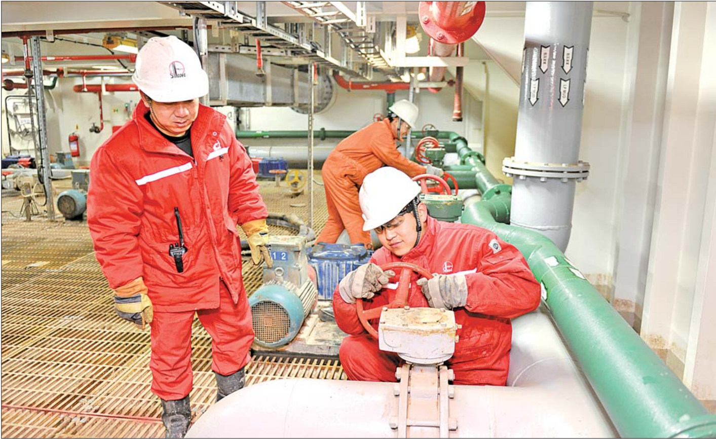
新胜利一号平钻井台正在进行泥浆回收作业。 通讯员 王为 摄
