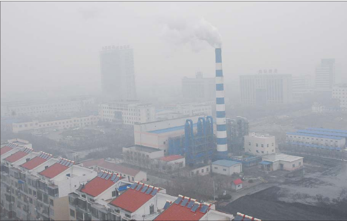
今年东营市将全面开展燃煤锅炉加装脱硫、脱硝装置的工作。 本报记者 段学虎 摄
