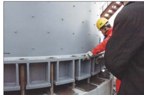
第一台加氢反应器正在安装。(图片由寰球公司提供)
