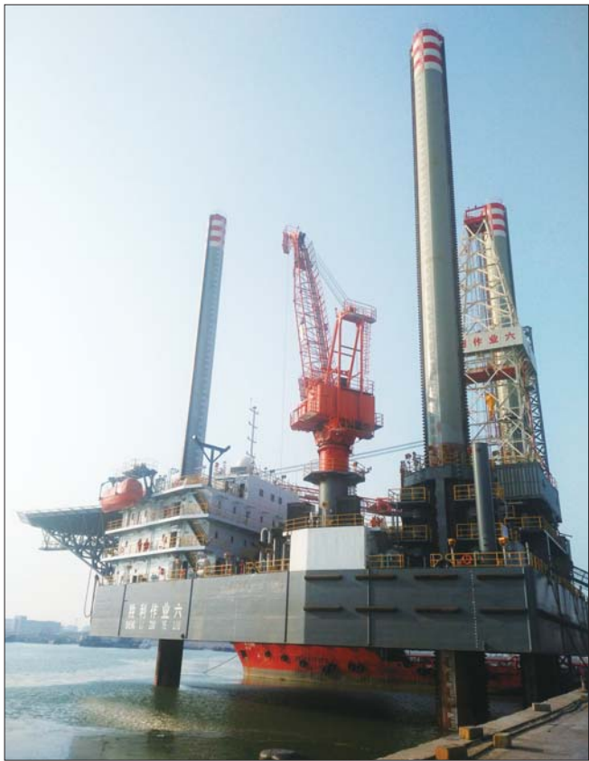
停靠在码头的“胜利作业六”平台。
