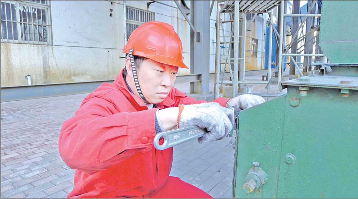
徐元锋正在检修管线。
