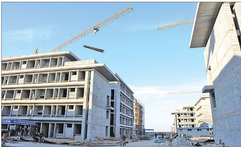
市一中新校区的新楼已全部封顶。 本报记者 段学虎 摄
