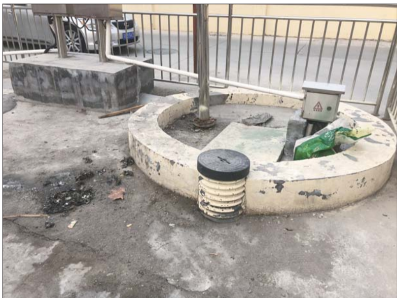
小区水泵所在的污水井,旁边为从抽水口中清理出的堵塞物。 本报记者 郭小雨 摄
